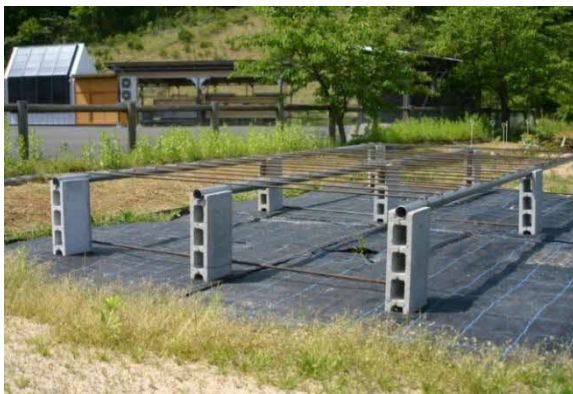
写真9 鋼管を使用した簡易コンテナ台
