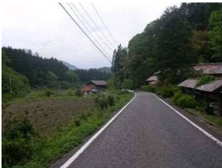
①未改良箇所
