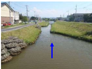
②暫定改修後状況 (R2.5)
