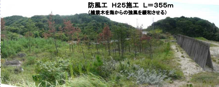
防風工 H25施工 L=355m (植栽木を海からの強風を緩和させる) 松くい虫被害により疎林化し飛砂防止機能が低下
