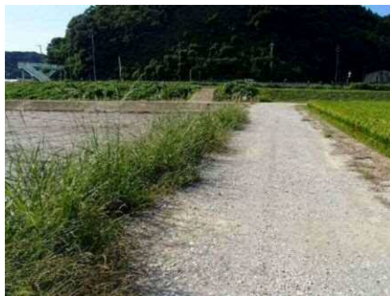
写真⑫ 福光地区 吹付1ヵ月前状況 (平成28年度施工箇所)
