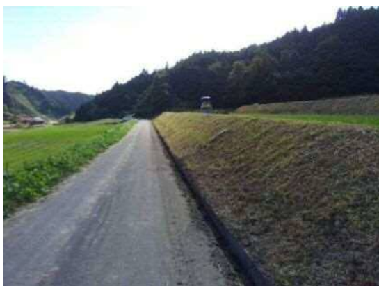
写真⑯ 野城地区 法面現況（草刈後）
