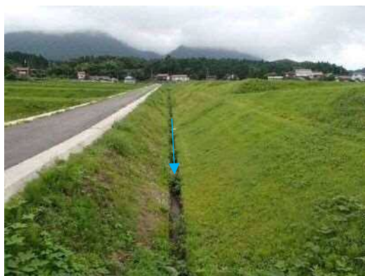
写真② 池田地区 排水路法面
