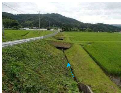
写真③ 池田地区 排水路と床版進入路
