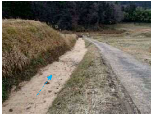
写真②⑥ 野城地区 1 号排水路施工前後
