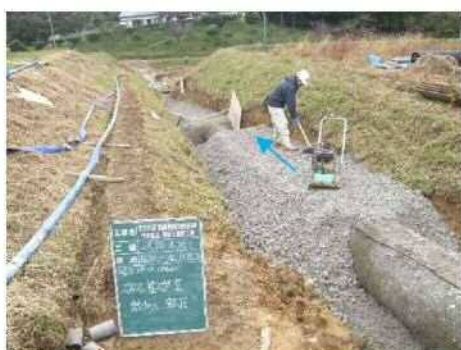
写真⑳ 伊木地区での暗渠工事
