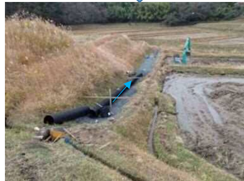
写真②⑦ 野城地区 2 号排水路施工前後
