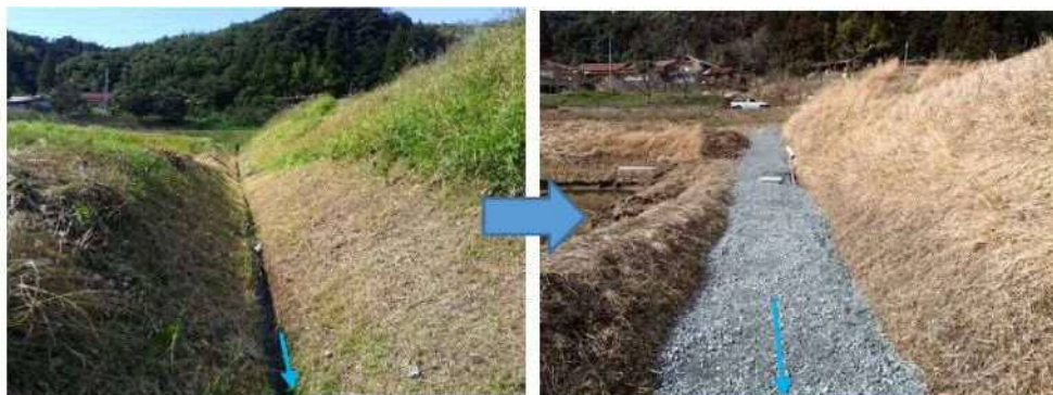
写真②⑤ 2号排水路埋戻前後（砕石まで埋戻した状況）
