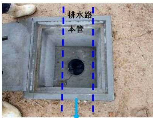
写真②⑥ 溜柵施工状況
