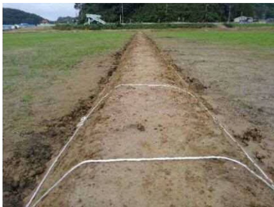
写真⑪ 福光地区 吹付前日状況 (平成29年度施工箇所)
