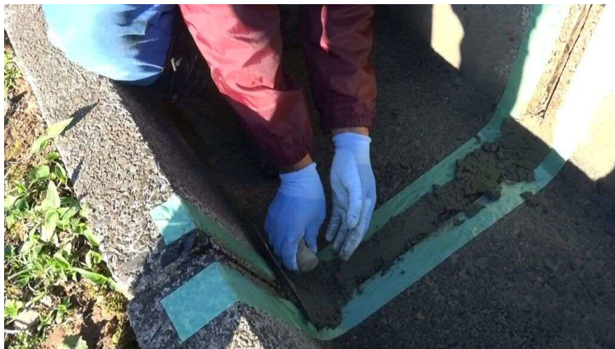
インスタントモルタルの施工イメージ
