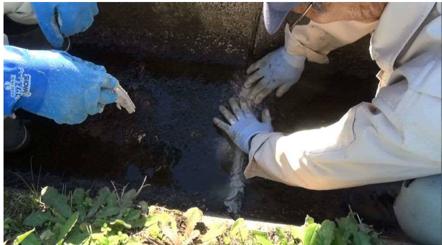
水中ボンド施工イメージ
