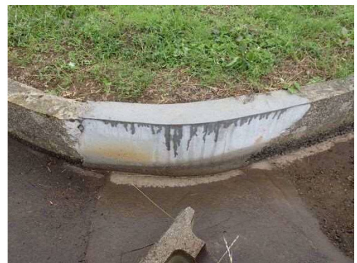
地元による補修
