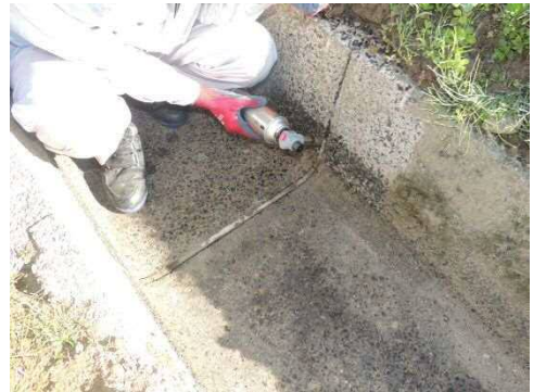
ガスバーナーを用いた乾燥作業
