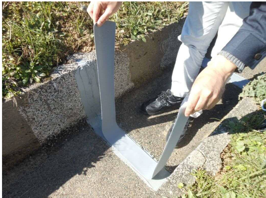
アグリパッチシール施工イメージ
