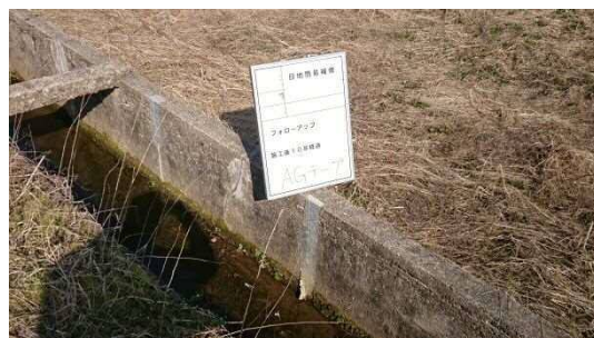
AGテープ施工
