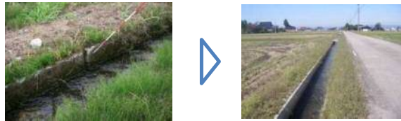
老朽化した水路の整備
