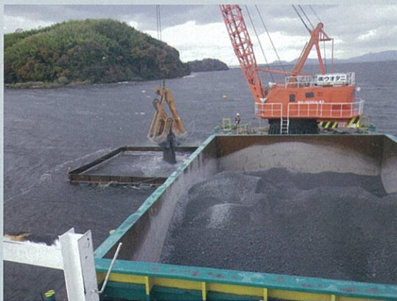
浚渫窪地へのHiビーズ投入
