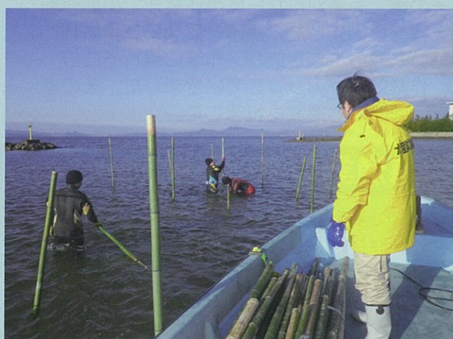
竹林礁の設置作業風景（平成24年12月27日）
