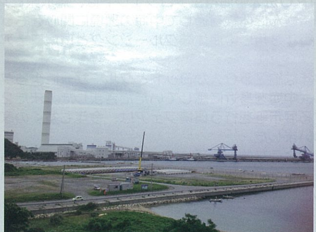
【三隅火力発電所】
