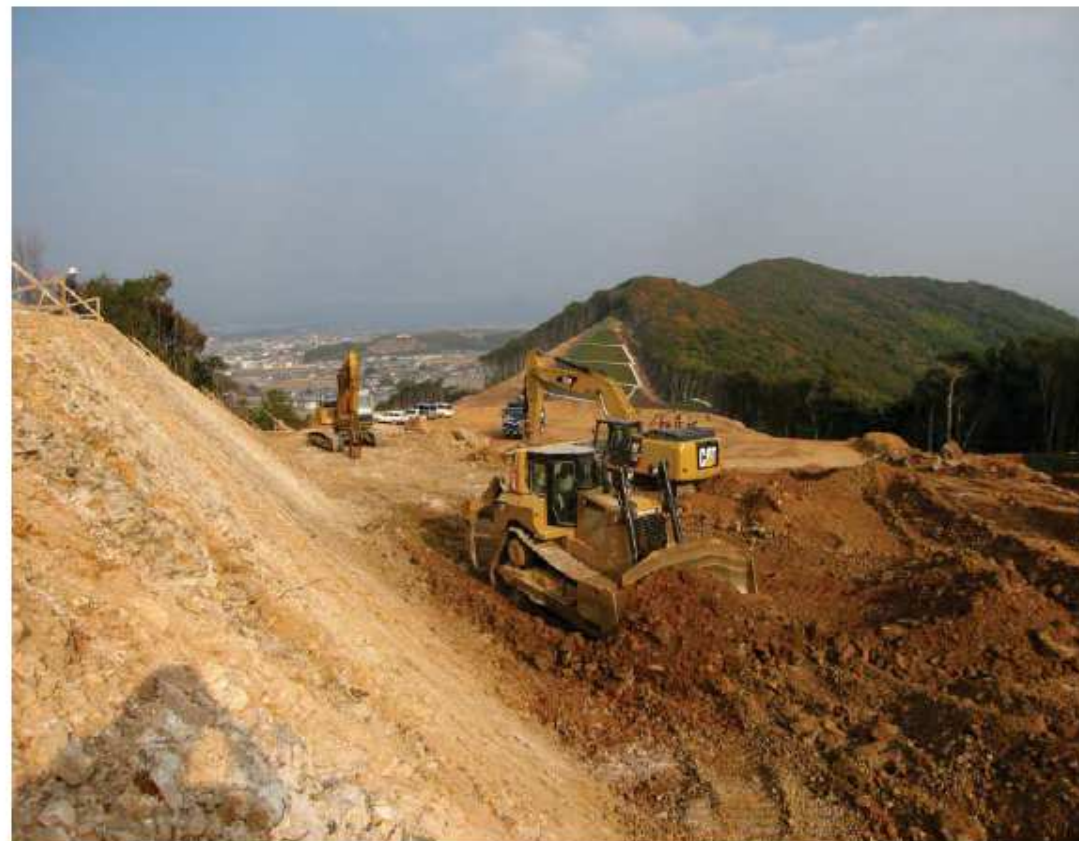
掘削(切土)施工中
