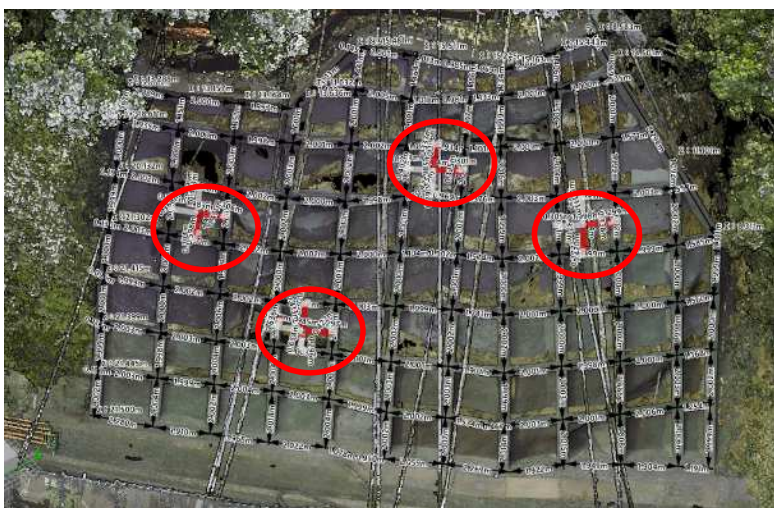
法枠出来形（枠延長）
