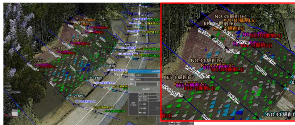
植生吹付工完了後によるTS出来形管理3次元座標を用いた出来形測定
