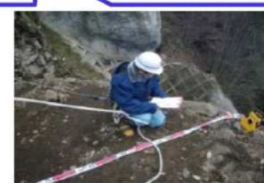
高所斜面上の臨場検査
