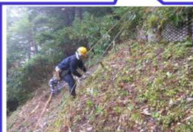
斜面上の測量作業
