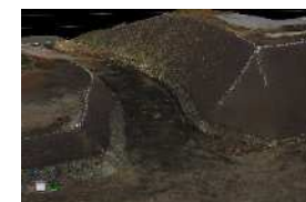
ICT活用工事(法面工)完了時
