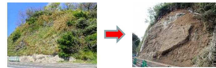
法面処理工及び維持修繕工事における施工基面
