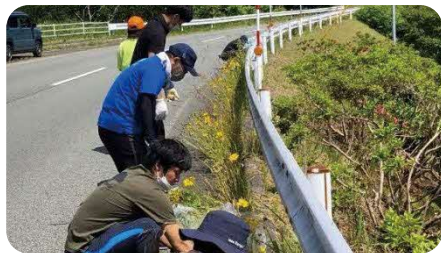
地道に手作業で抜き取る様子
