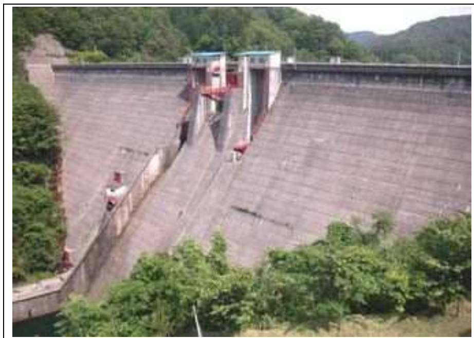
写真 7.4-9 布部ダム（下流面）
