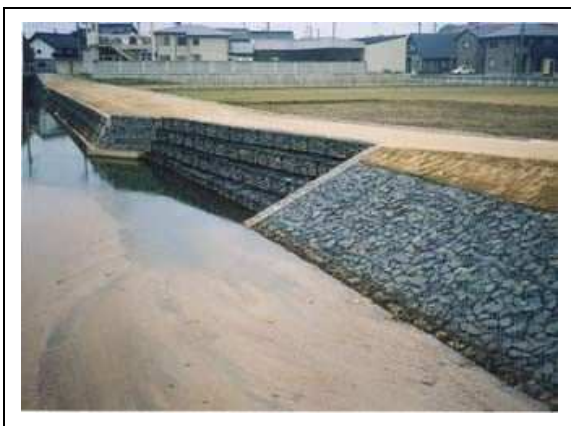
写真 7.4-13 木戸川（下流工区）
