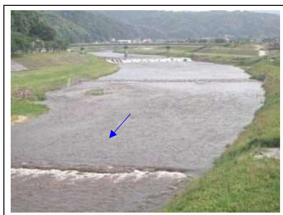
写真 7.4-3 飯梨川（新宮橋より上流）
