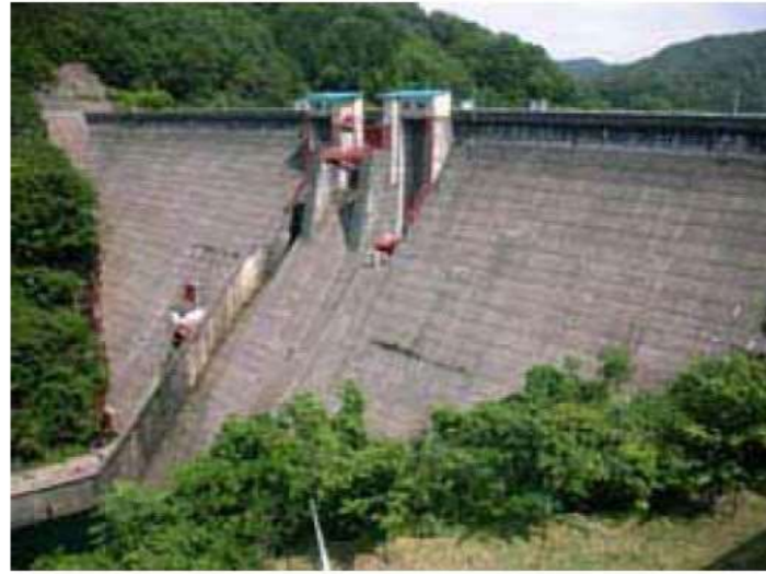
写真-6 布部ダム
