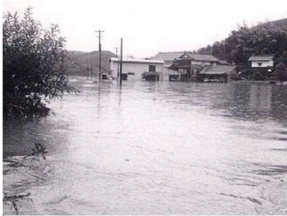
写真-1 津田平川の氾濫（昭和 47 年 7 月）
