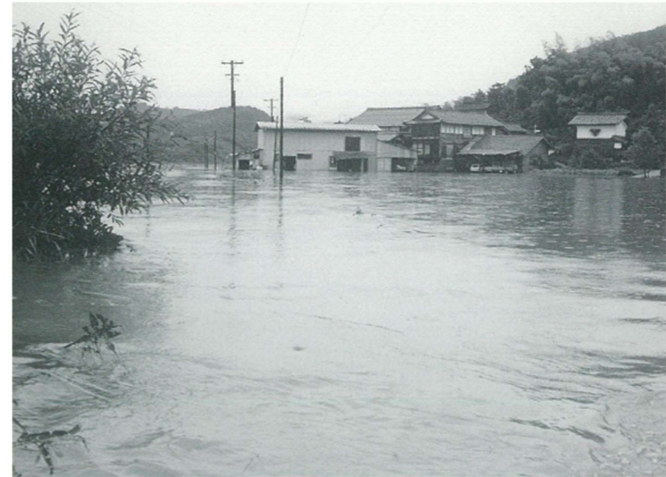
写真 3.1-1 津田平川の氾濫（昭和 47 年 7 月）
