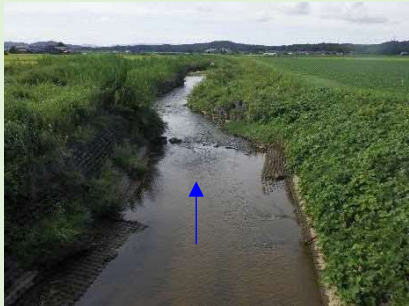
ながどうろ大橋下流
