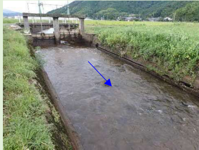
西中津水門付近
