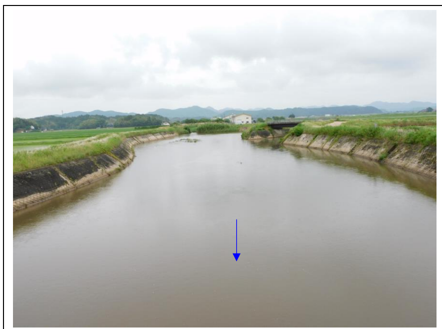
写真 7.4-12 吉田川（瀬崎橋の上流）
