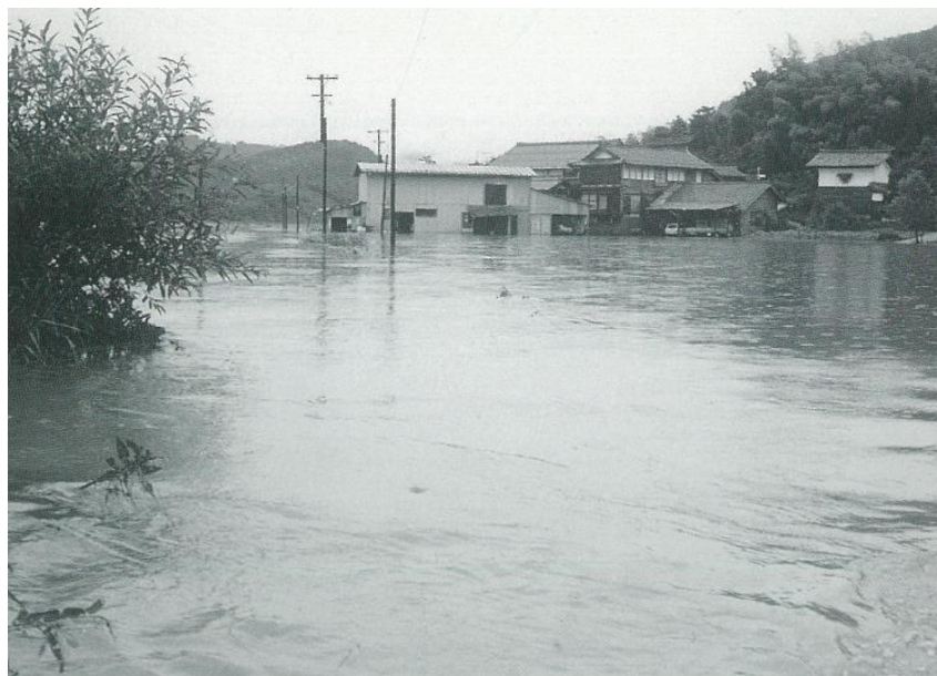
写真 7.1-5 津田平川の氾濫による浸水
