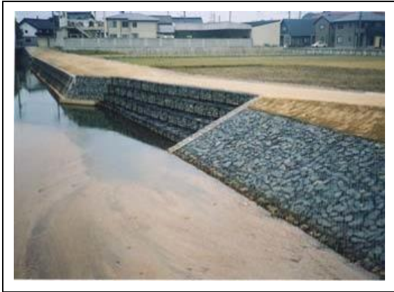
写真7.4-13 木戸川（下流工区）
