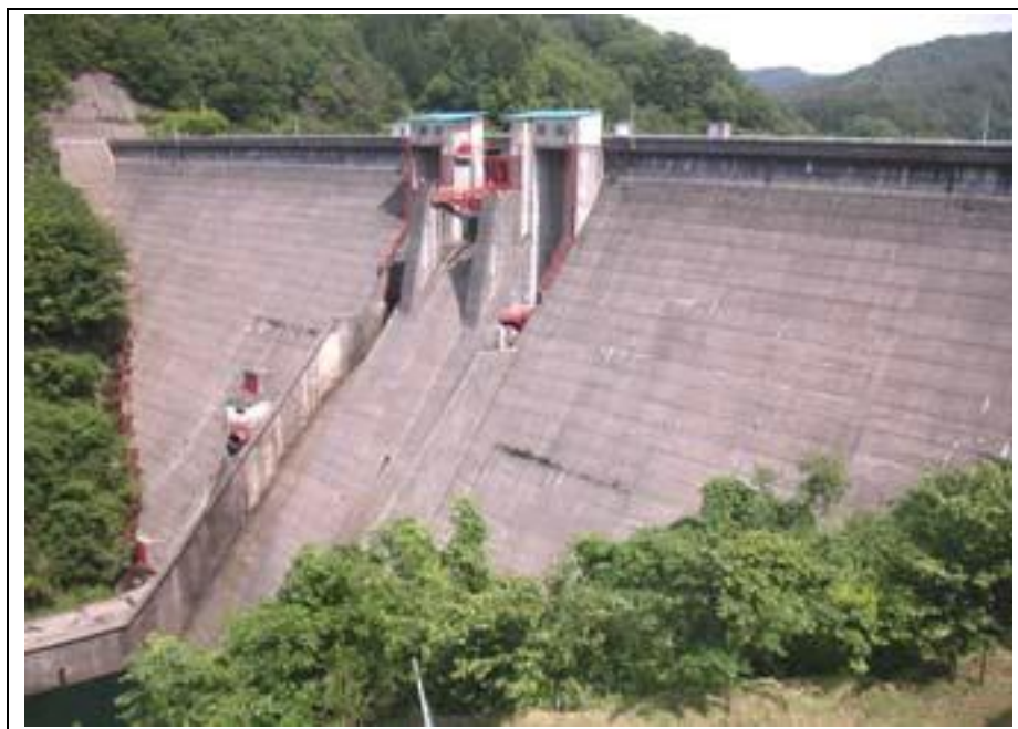
写真 7.4-9 布部ダム（下流面）
