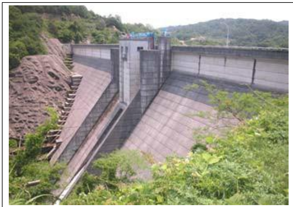
写真 7.4-10 山佐ダム（下流面）
