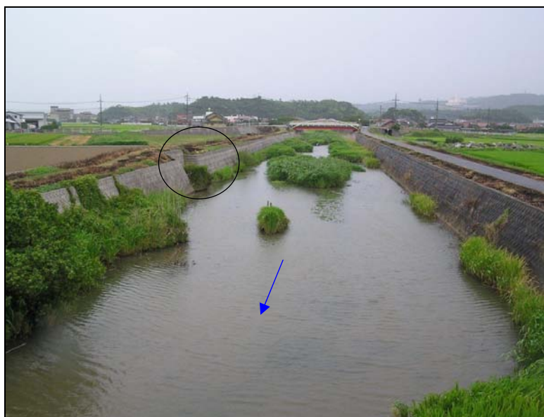
写真12-2 整備状況（十間川：佐伯橋～小浜大橋間）
