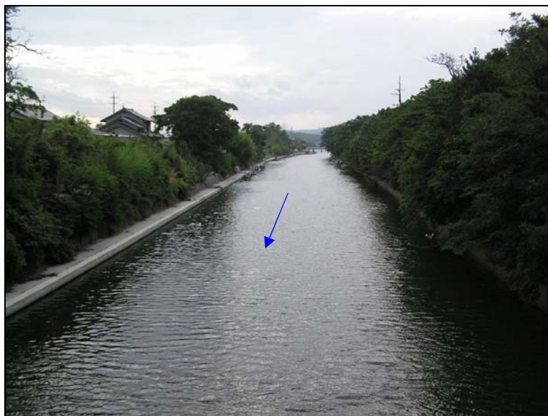
写真12-1 整備状況（差海川：中橋～差海大橋間）
