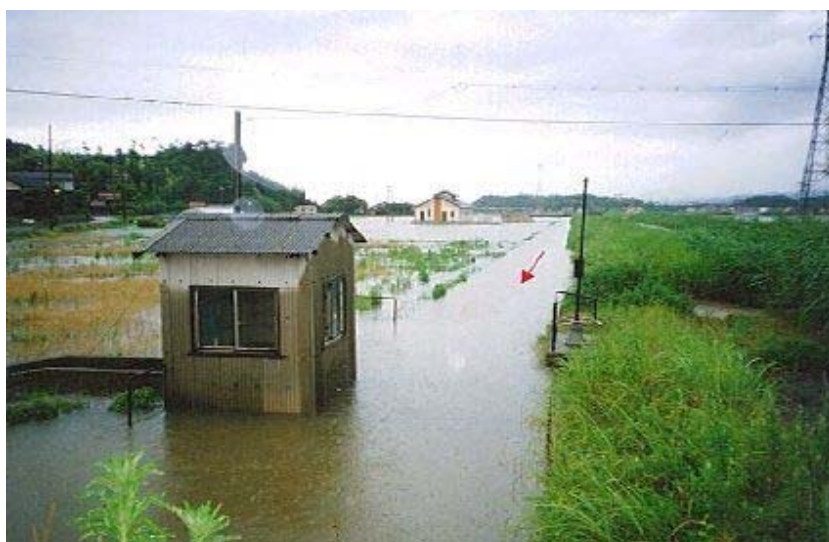
写真9 - 5 九景川排水路下流
