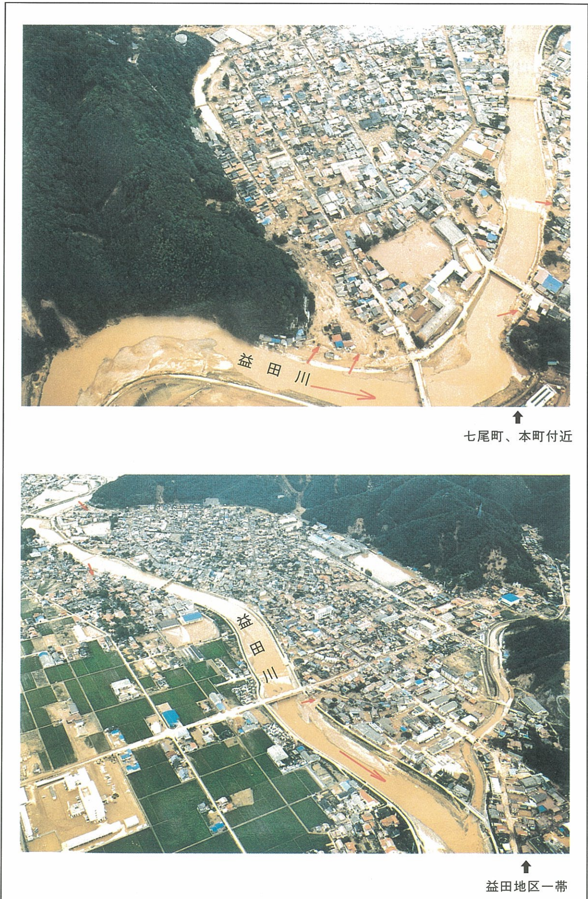
写真－3.1 被災状況（昭和58年7月災害）
