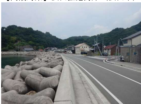
【高潮対策】浜田漁港海岸（浜田市）
