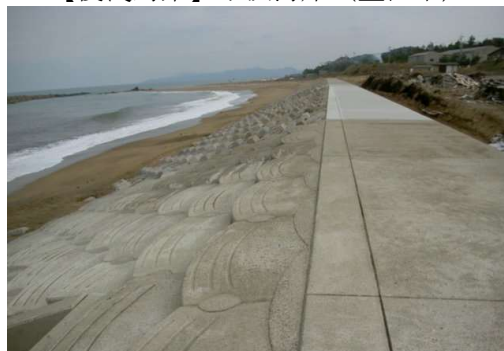
【侵食対策】小浜海岸（益田市）
