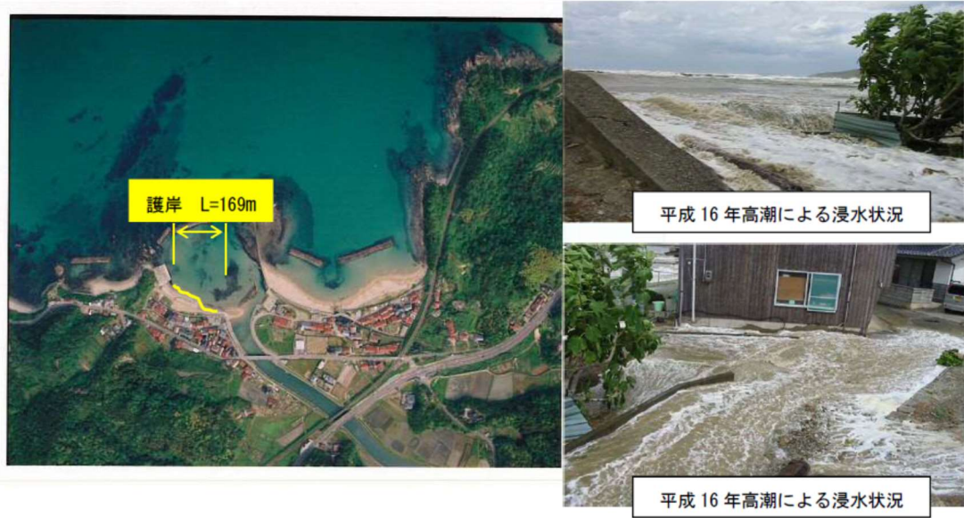
写真- 1.9 高潮による浸水被害の事例
