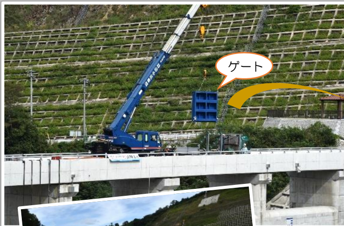
◀ クレーンによるゲートの設置作業
