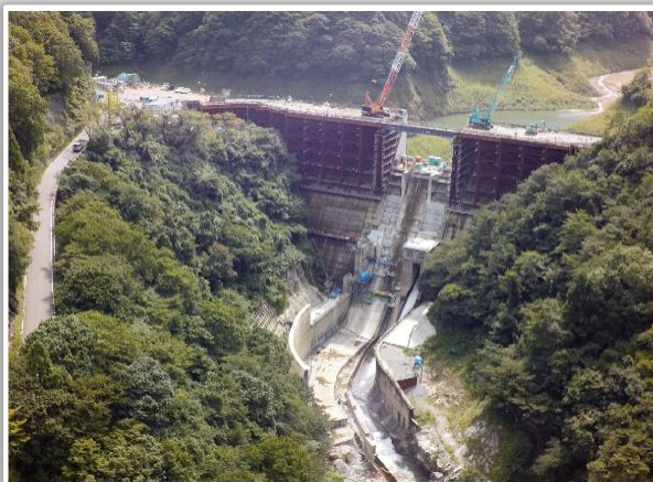
施工中の浜田ダム (平成29年9月撮影)
