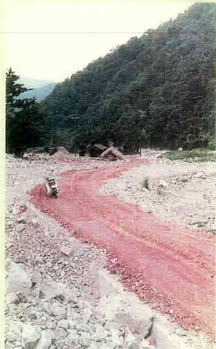
懸命の復旧作業によって通れる状態になった道路
