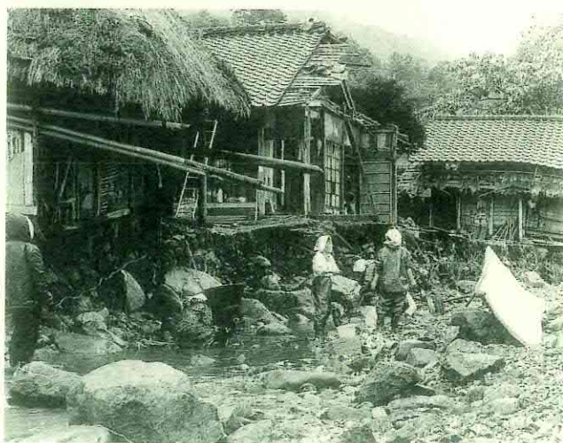
土石流に襲われた家屋（鹿足郡六日市町）
