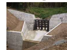
砂防えん堤工
