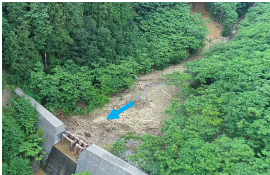
土石流発生直後 (R3.7.15 撮影)
