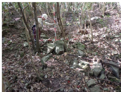
<写真2：点検・調査の様子>
