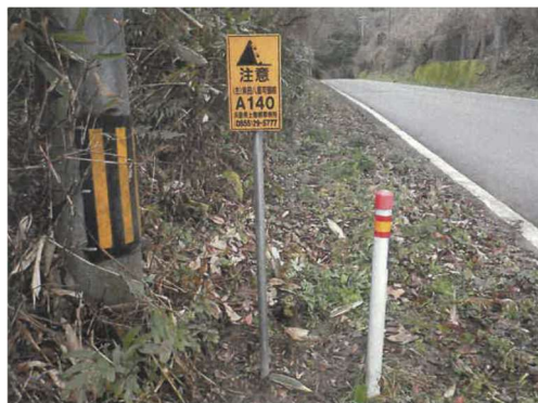
<写真1：危険箇所番号標>
