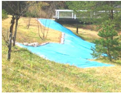
シートによる斜面の防護
