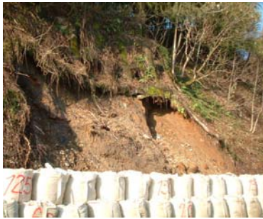
土嚢積みによる斜面の抑制
