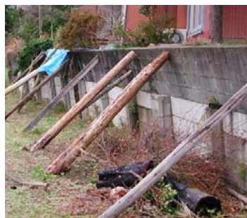
頬杖による擁壁倒壊防護
