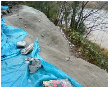
モルタル吹き付け及びロックボルトによる斜面防護
