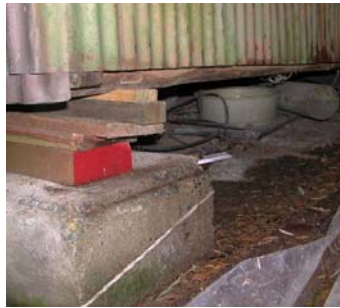
木材等による建築基礎の嵩上げ
