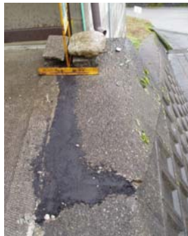
アスファルト充填による擁壁天端亀裂防護
