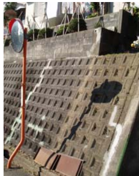
モルタル充填による亀裂の防護
