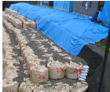
シートによる擁壁背面の亀裂の防護
