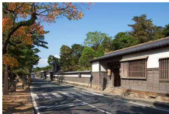
景観地区 (松江市)
