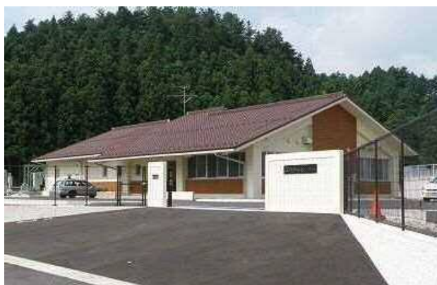
西郷浄化センター（隠岐の島町）
