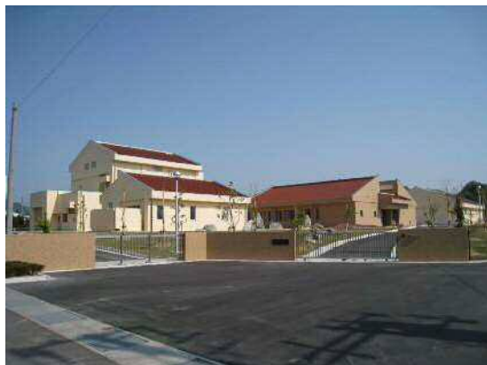
大田浄化センター（大田市）
