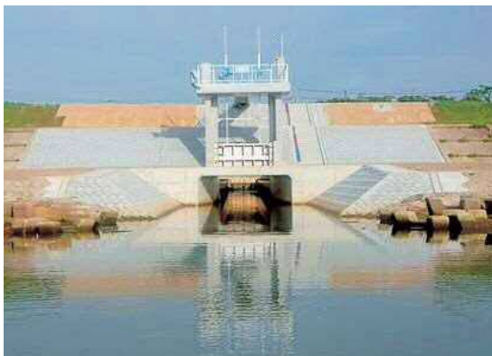
万葉都市下水路樋門（益田市）
