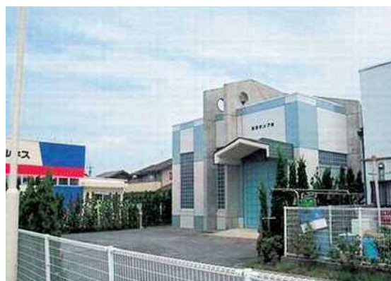
黒田中継ポンプ場（松江市）
