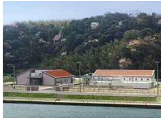
国府浄化センター（浜田市）
