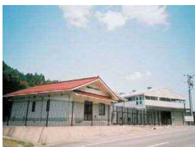
大田市リサイクルセンター (大田市)
