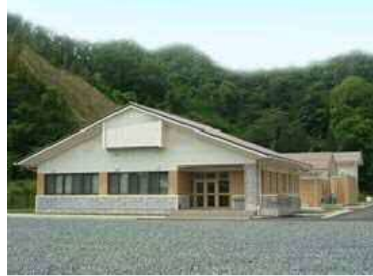
大東浄化センター（雲南市）
