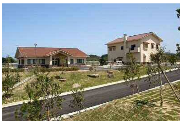
益田水質管理センター（益田市）
