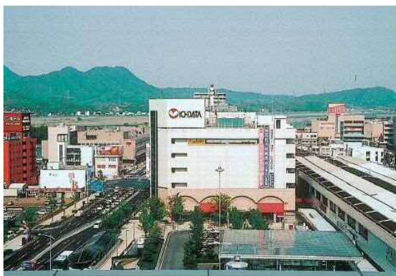
松江駅前地区第一種市街地再開発事業（松江市）
