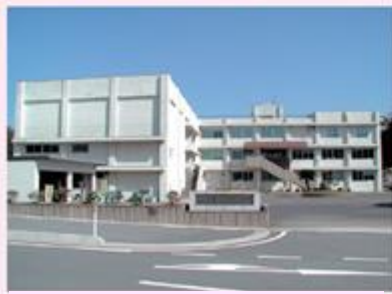
総合調整部・漁業生産部 浜田駅から車で10分 萩・石見空港から車で60分
